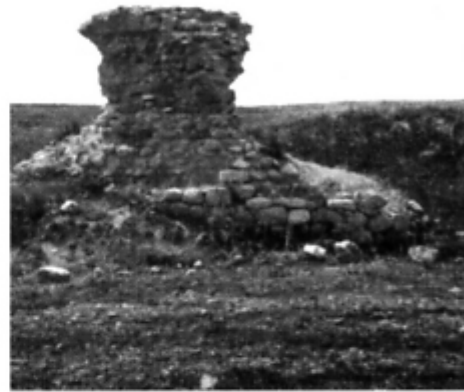
Fig. 35 - Particolare del torrione di Casalenovum.
